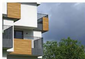
Kaskády Hranice Hranice, 2018
