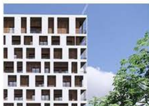
Kaskády Hranice Hranice, 2018
