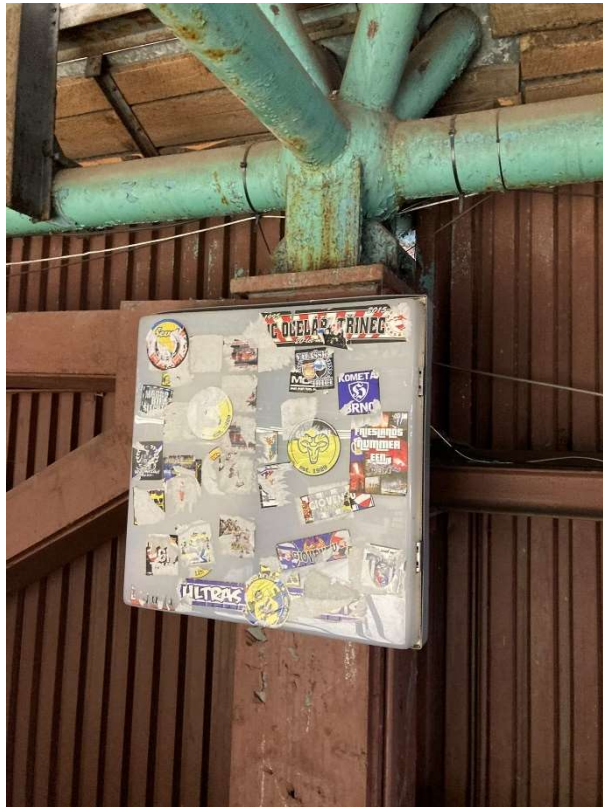
Svítidlo v dosahu veřejnosti se znečištěným krytem
