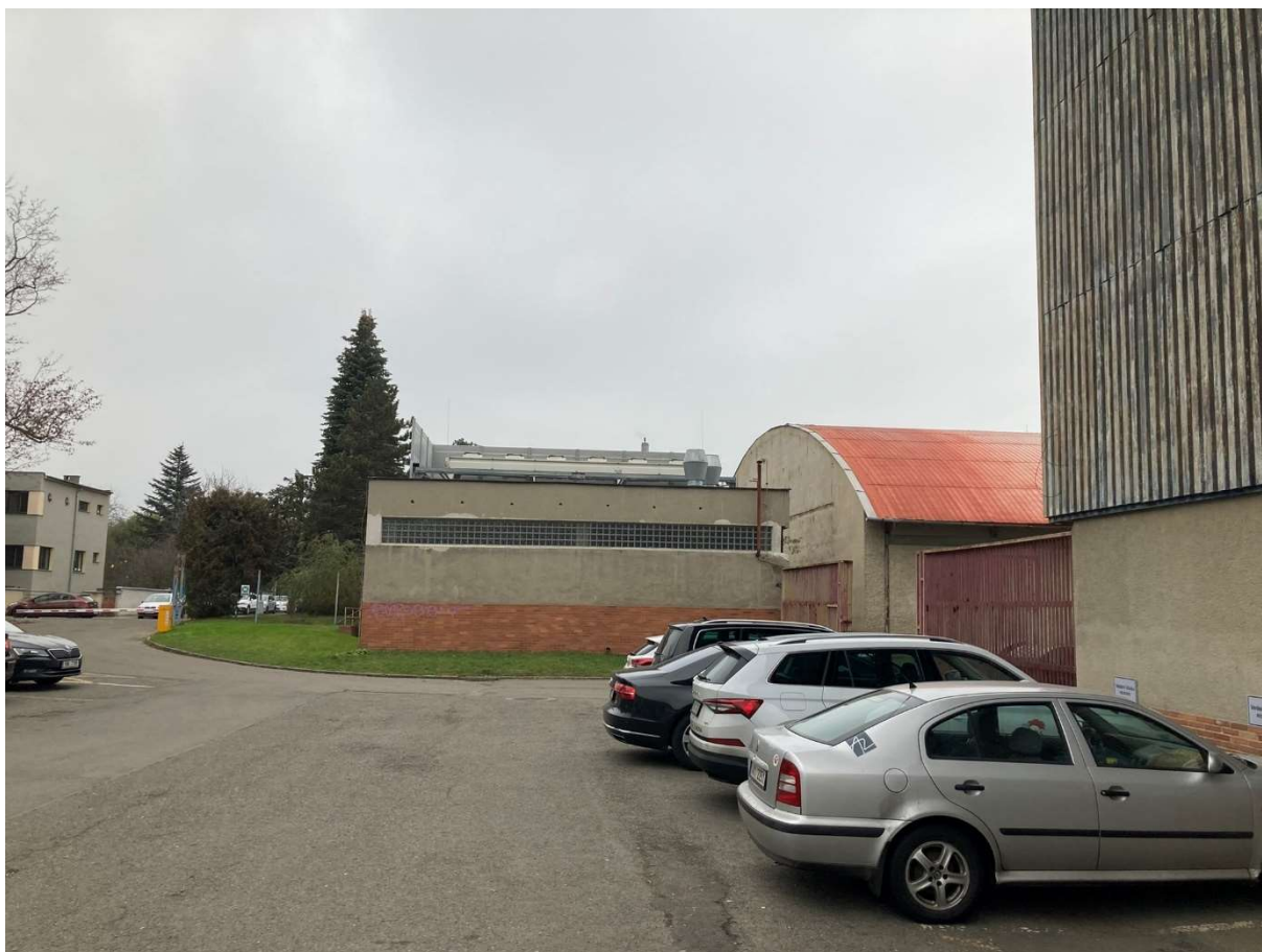
Pohled na budovy technologického zázemí (technologie střechy s jímací soustavou)
