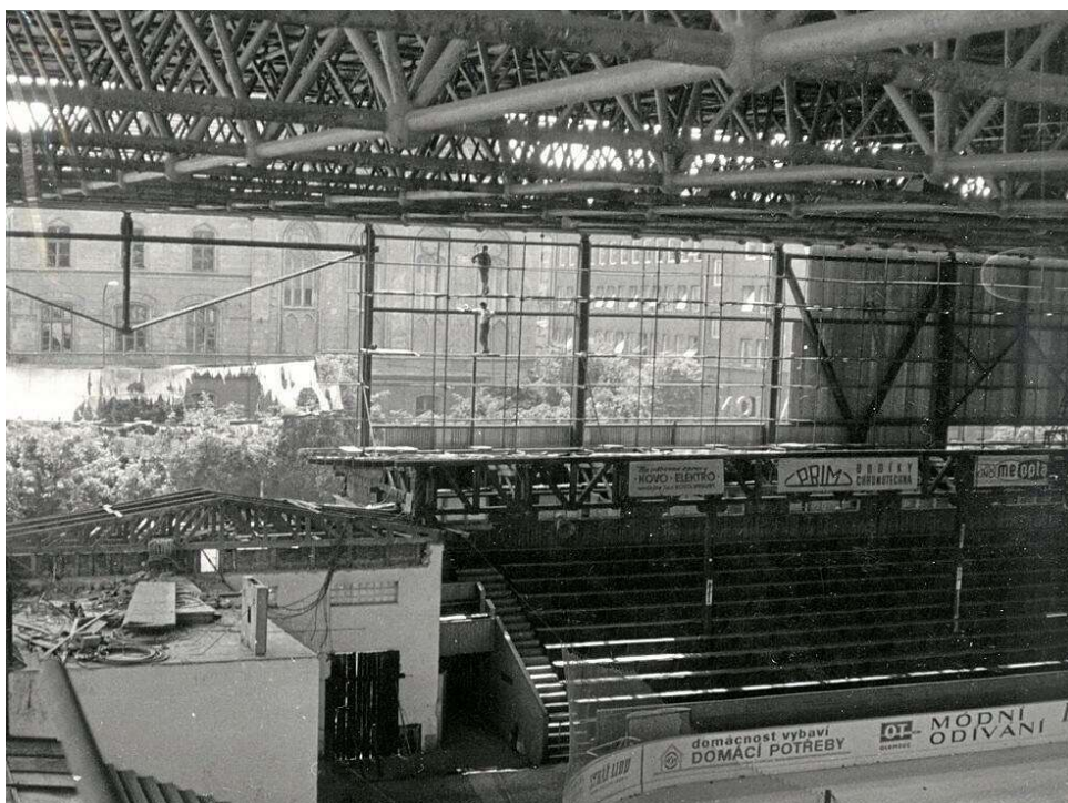
Rekonstrukce opláštění haly
