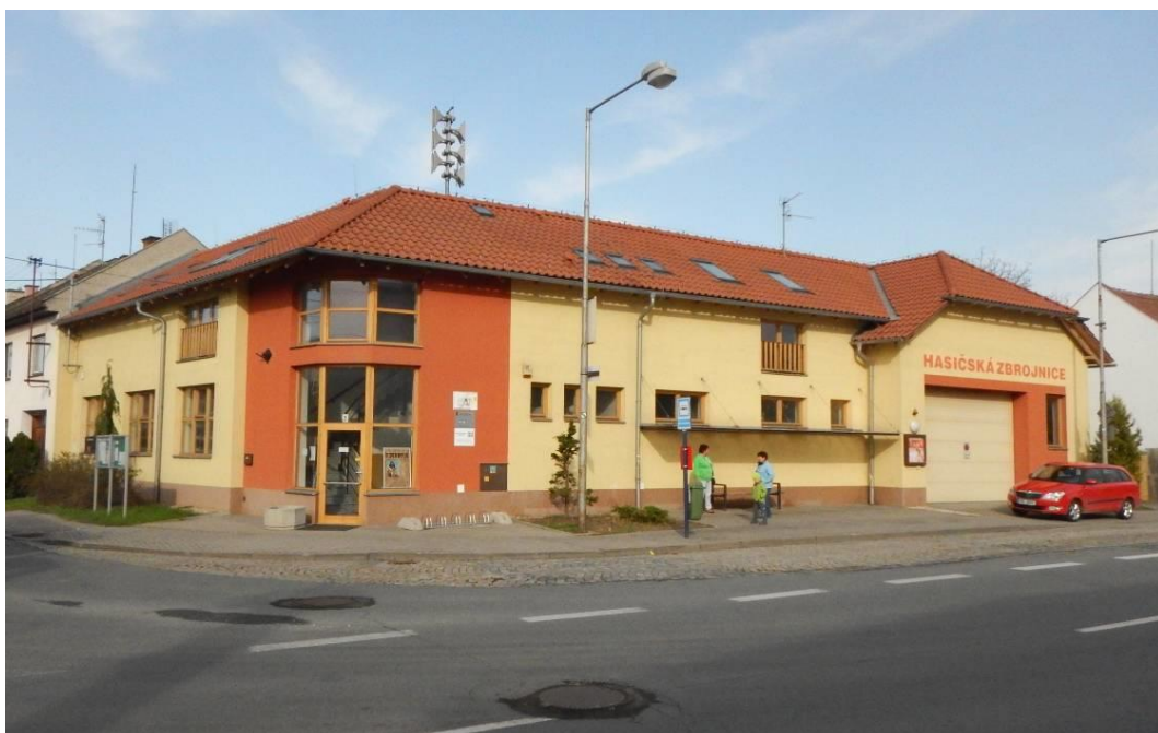
Obrázek 10 - Hasičská zbrojnice Chomoutov - pohled
