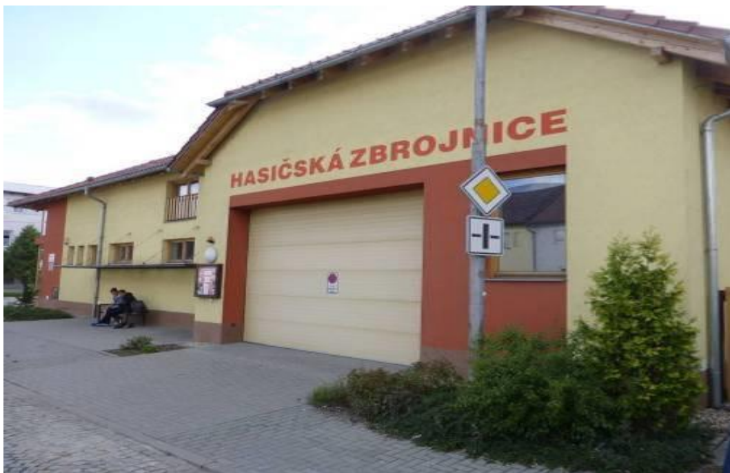
Obrázek 9 - Hasičská zbrojnice Chomoutov - pohled
