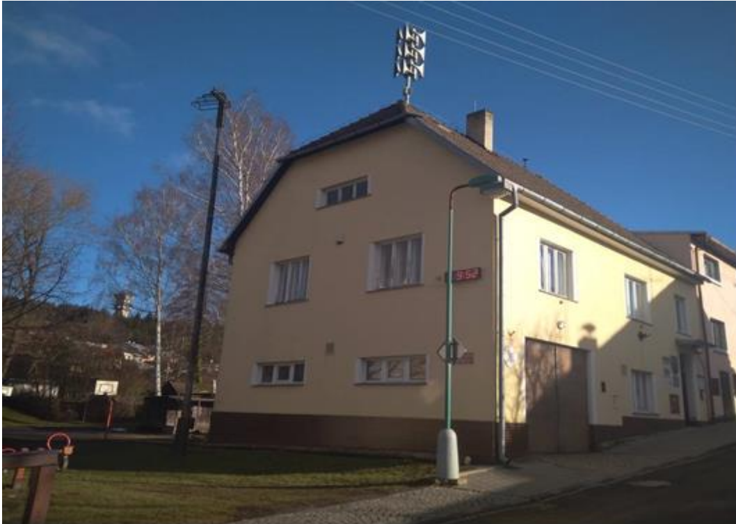
Obrázek 17 - Hasičská zbrojnice Radíkov - pohled
