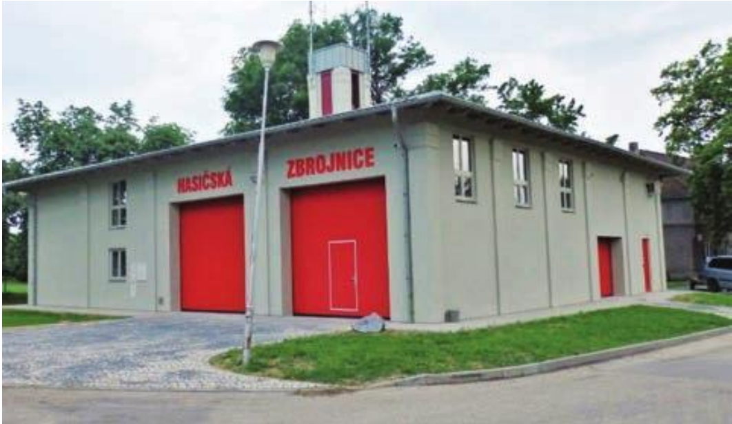
Obrázek 11 - Hasičská zbrojnice Chválkovice (nová) - pohled
