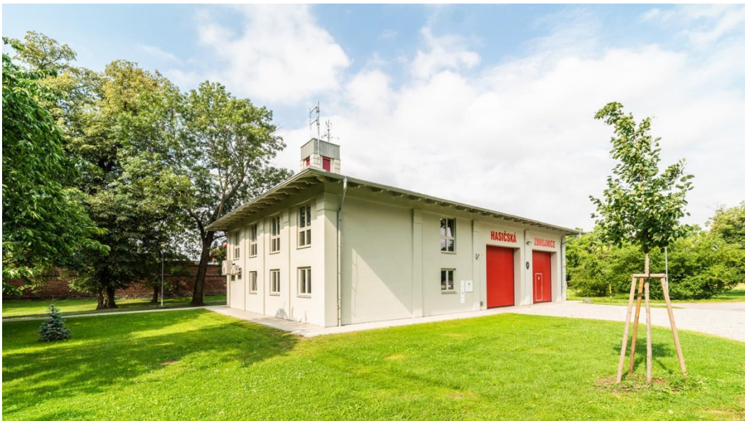
Obrázek 12 - Hasičská zbrojnice Chválkovice (nová) - pohled
