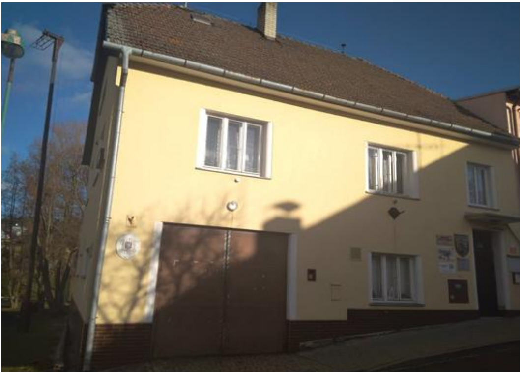
Obrázek 18 - Hasičská zbrojnice Radíkov - pohled
