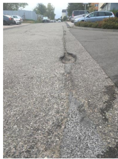
Foto č. 3 oprava silnice Profesora Fuky
